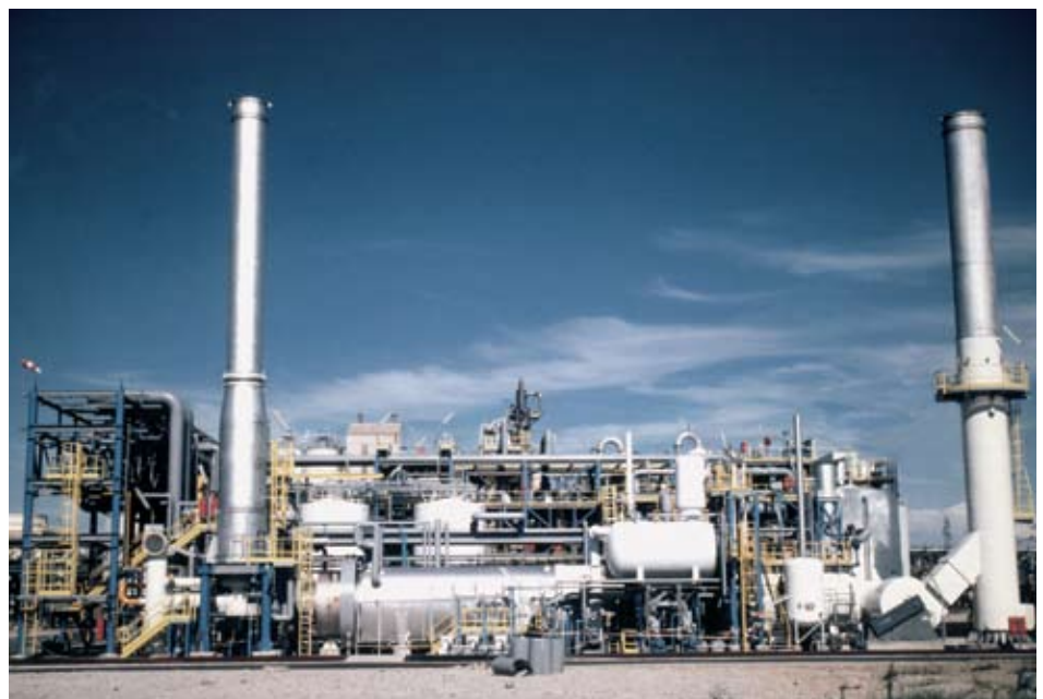
Low NO x (deNO x idizer™) Thermal Oxidizer
